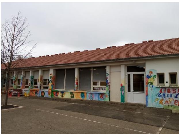
Réfection du toit de l'école
