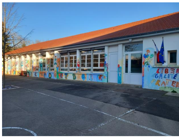
Toit fini, porte neuve, volets roulants installés
